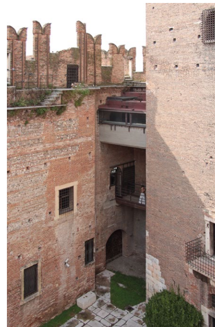
Bild över västra innergården.
