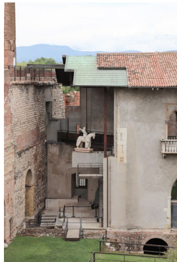
Muren är frigjord från 1920-talsbyggnaden, för att förstärka dess historiska lager.
