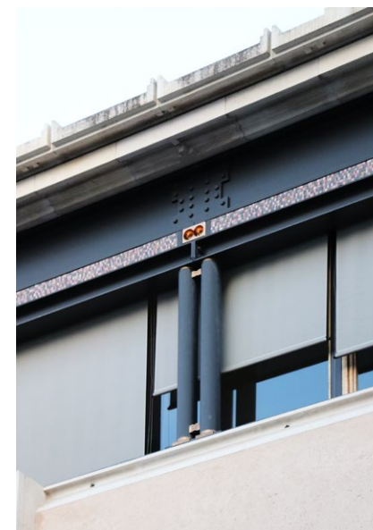
Övre fasaddetaljer, vid takfoten. Notera mosaiken som bildar en relief ovanför den svarta stål balken.
