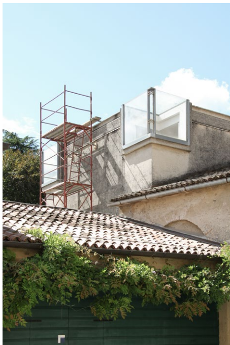
Pågående underhåll av utbyggnaden.
