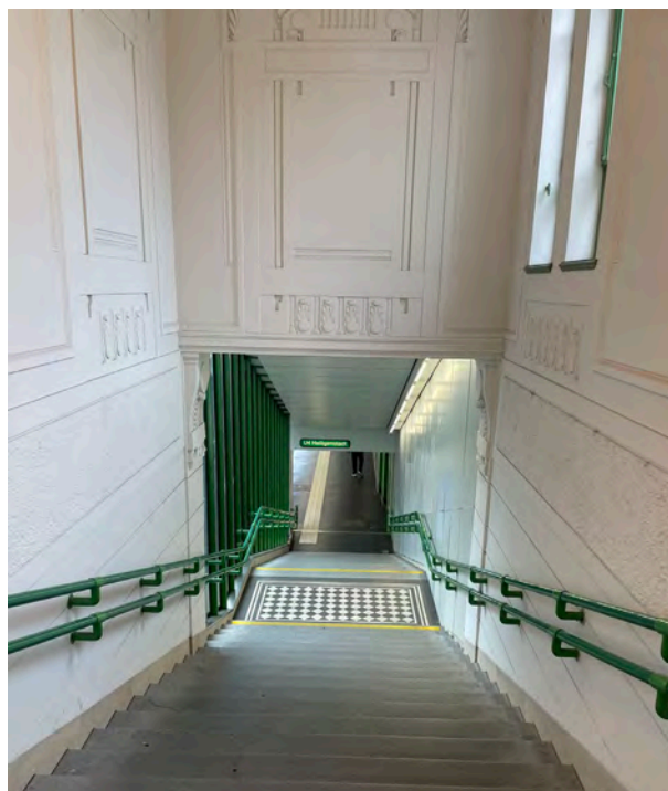
Typisk trappa ner till plattformen på stationerna ritade av Wagner.
