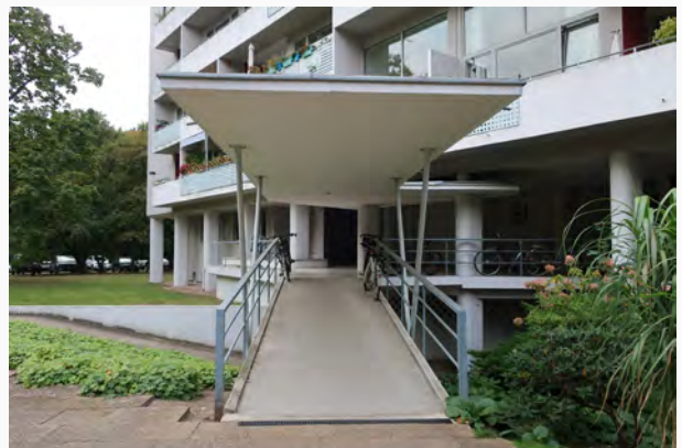
Arkitekt: Pierre Vago
